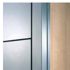
Ecklösung: Hier mit Vollwand-Segmenten, die mit erhöhtem Schallschutz ausgestattet sind, als 90°-Ecke.
